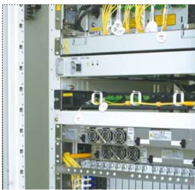
ギガビット光アクセス装置「BX8000」 および、光センタ装置「BX9000」
